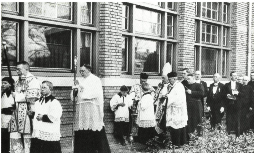
Inzegening HBS gebouw aan de Mierloseweg
